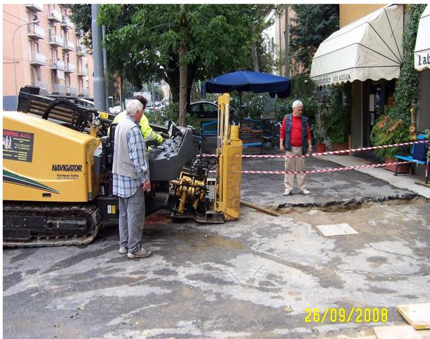
Figura 10 – Realizzazione delle perforazioni “No Dig”
