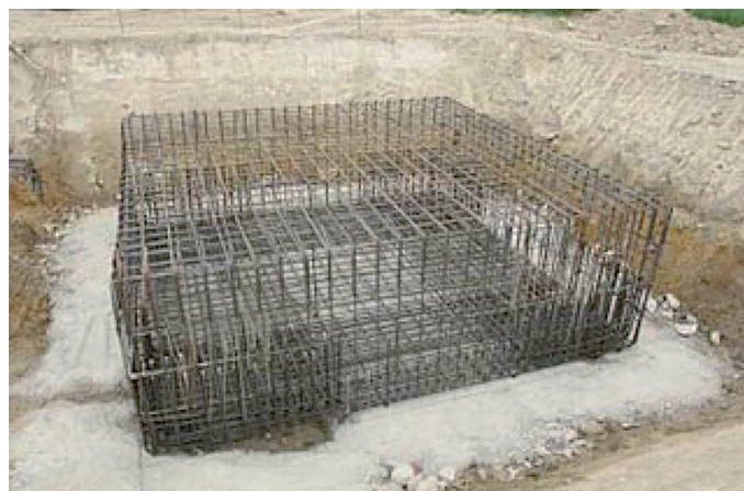
Fig. 12 - esempio di configurazione esecutiva di un plinto di fondazione.
